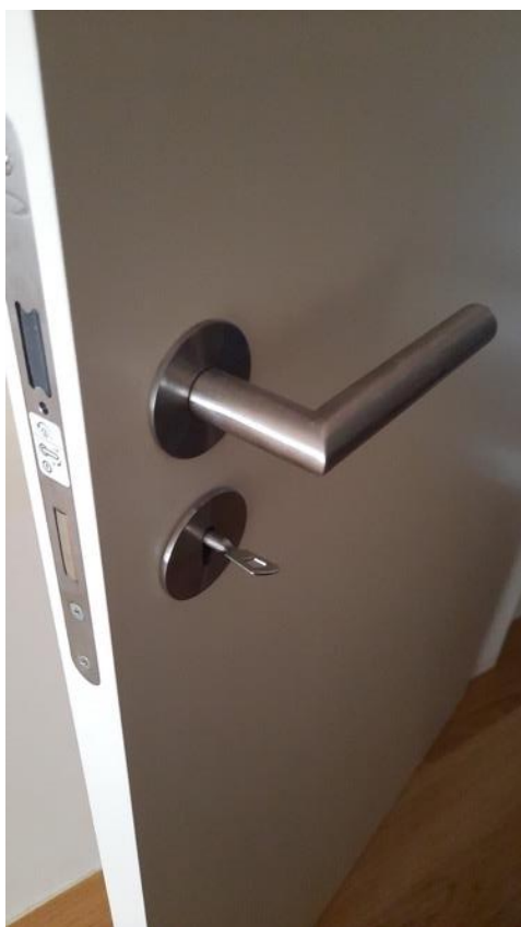
Zoom – poignet et serrure porte – côté salle (système aimanté)
